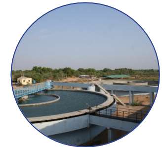
Impianti di trattamento delle acque in Israele, 11/2023
